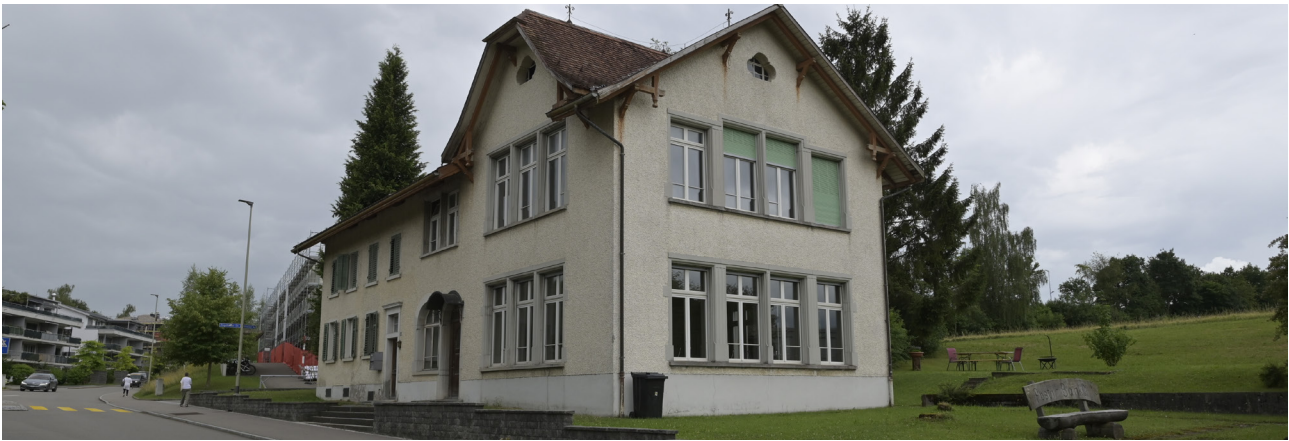
Jakob-Stutz-Strasse 54, Ansicht von Nordosten [vestigia 08.06.2022]
