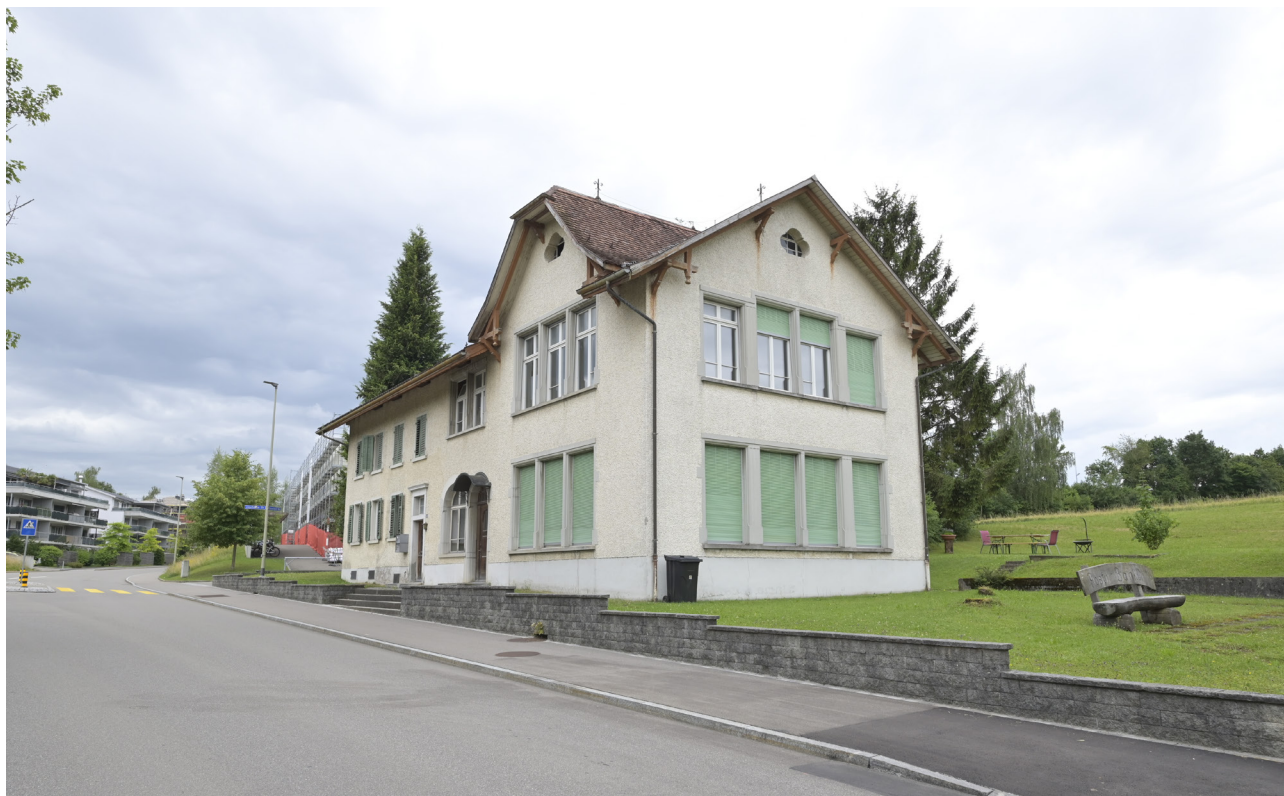
Jakob-Stutz-Strasse 54, Ansicht von Nordosten [vestigia 08.06.2022]
