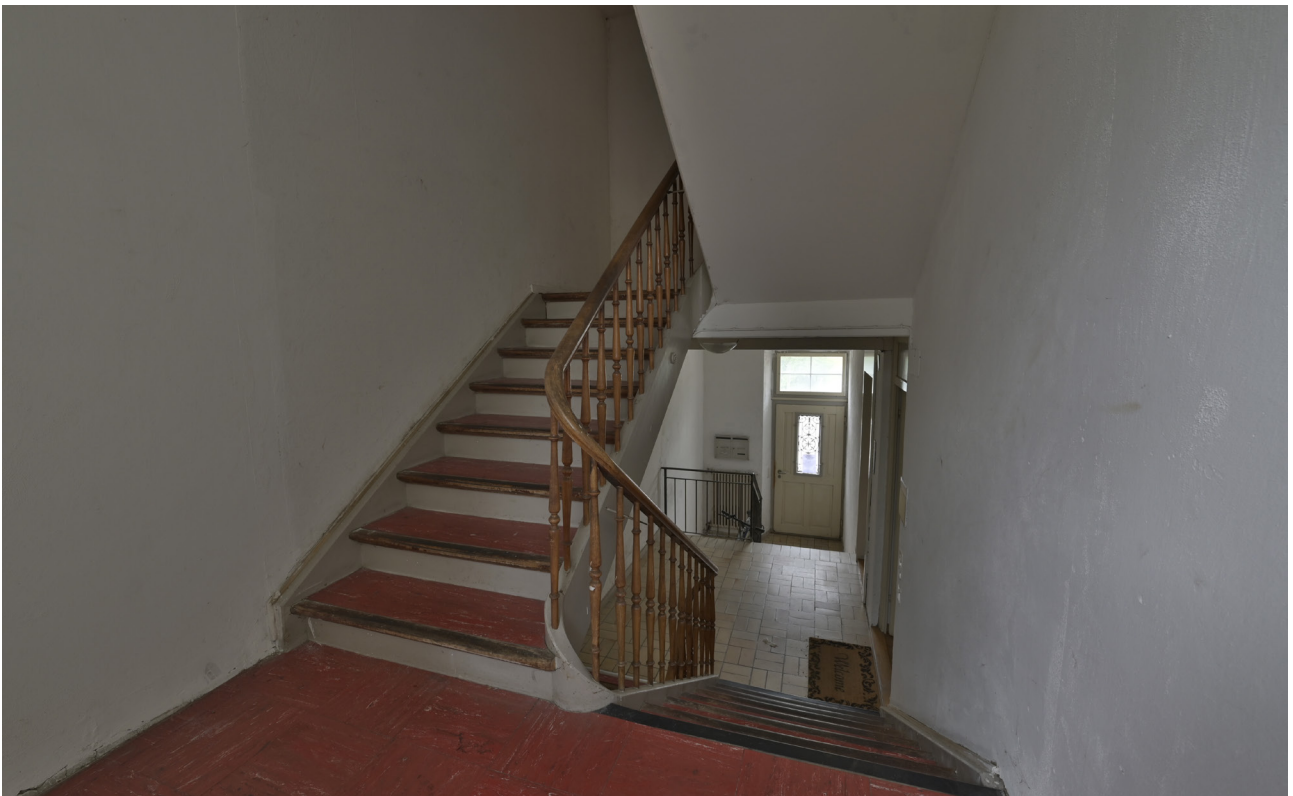
Jakob-Stutz-Strasse 54, Ansicht des Treppenhauses im Wohnhaus [vestigia 08.06.2022]
