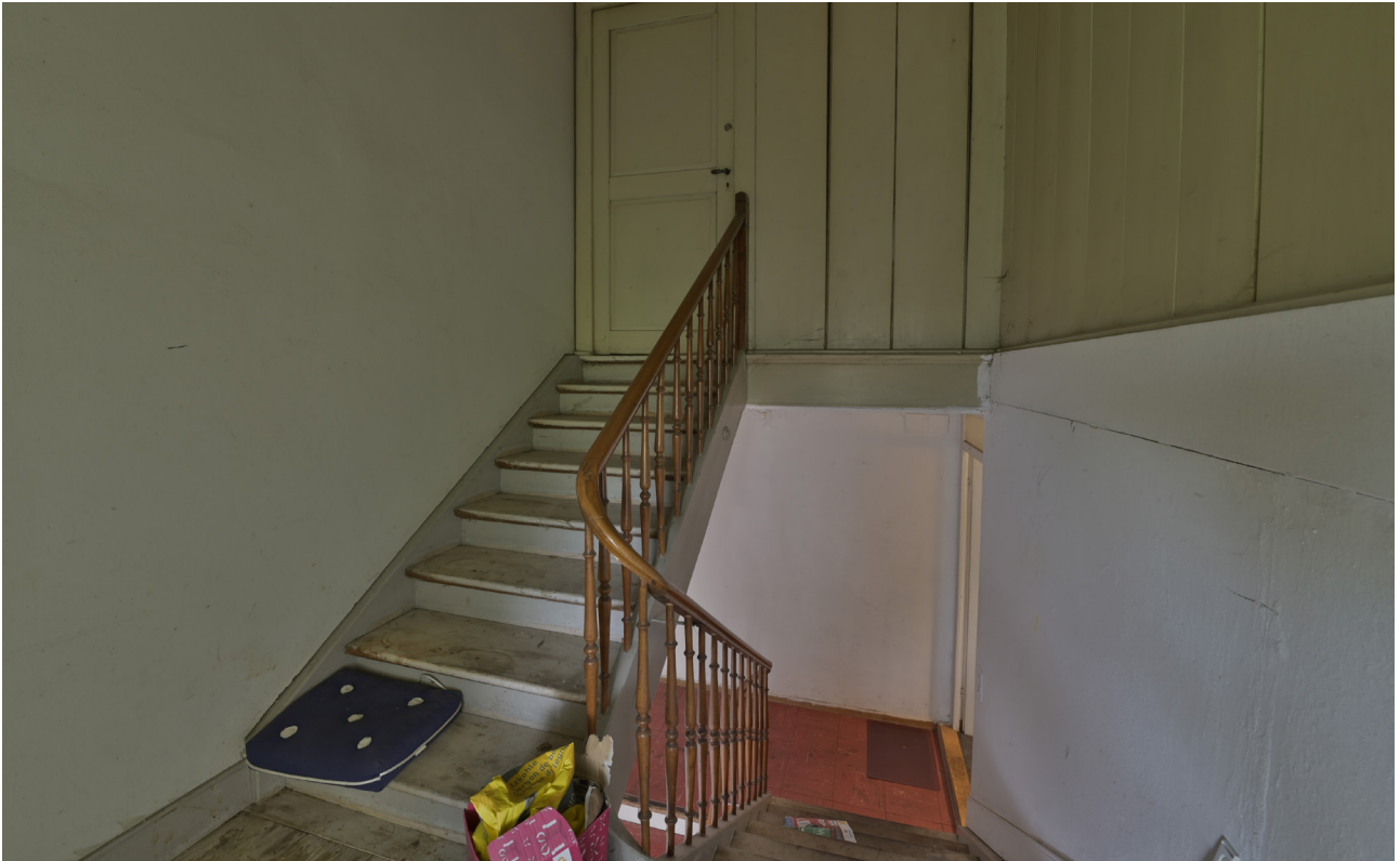
Jakob-Stutz-Strasse 54, Ansicht des Treppenaufgangs in den Estrich im Wohnhaus [vestigia 08.06.2022]
