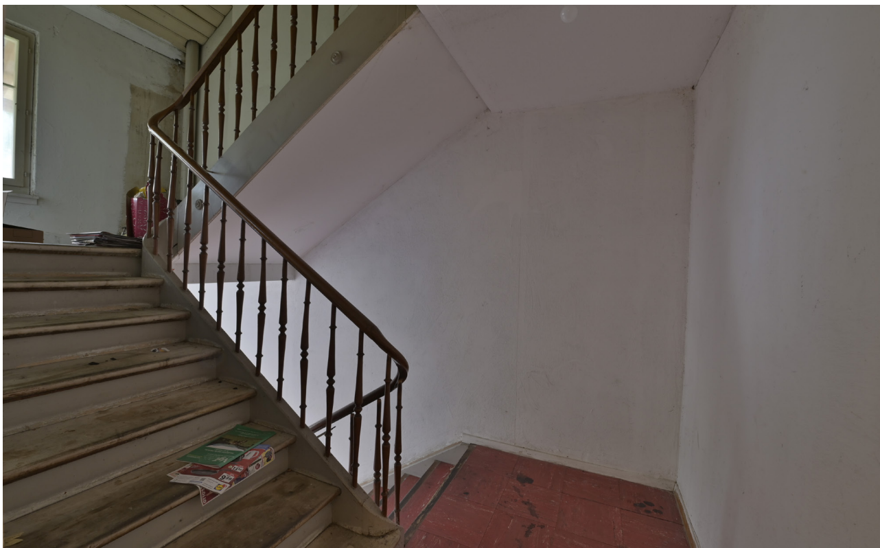
Jakob-Stutz-Strasse 54, Ansicht des Treppenhauses [vestigia 08.06.2022]
