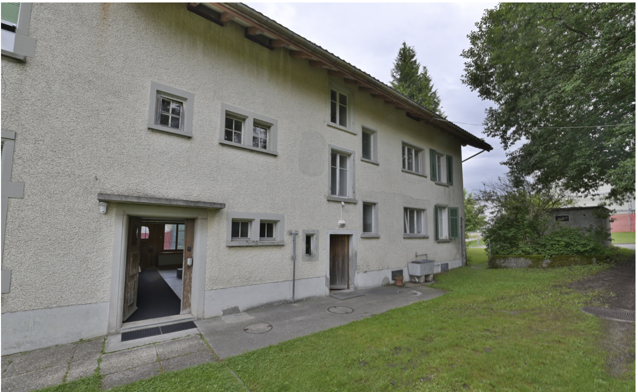
Jakob-Stutz-Strasse 54, Ansicht der rückseitigen Eingangsbereiche [vestigia 08.06.2022]
