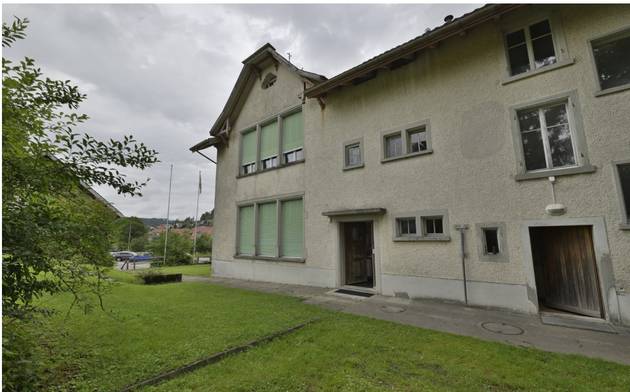
Jakob-Stutz-Strasse 54, Ansicht der rückseitigen Eingänge [vestigia 08.06.2022]
