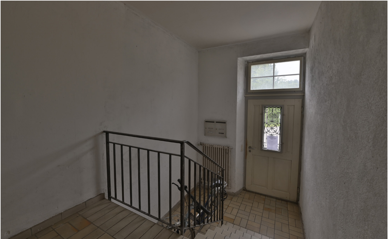
Jakob-Stutz-Strasse 54, Ansicht des strassenseitigen Eingangsbereichs ins Wohnhaus [vestigia 08.06.2022]
