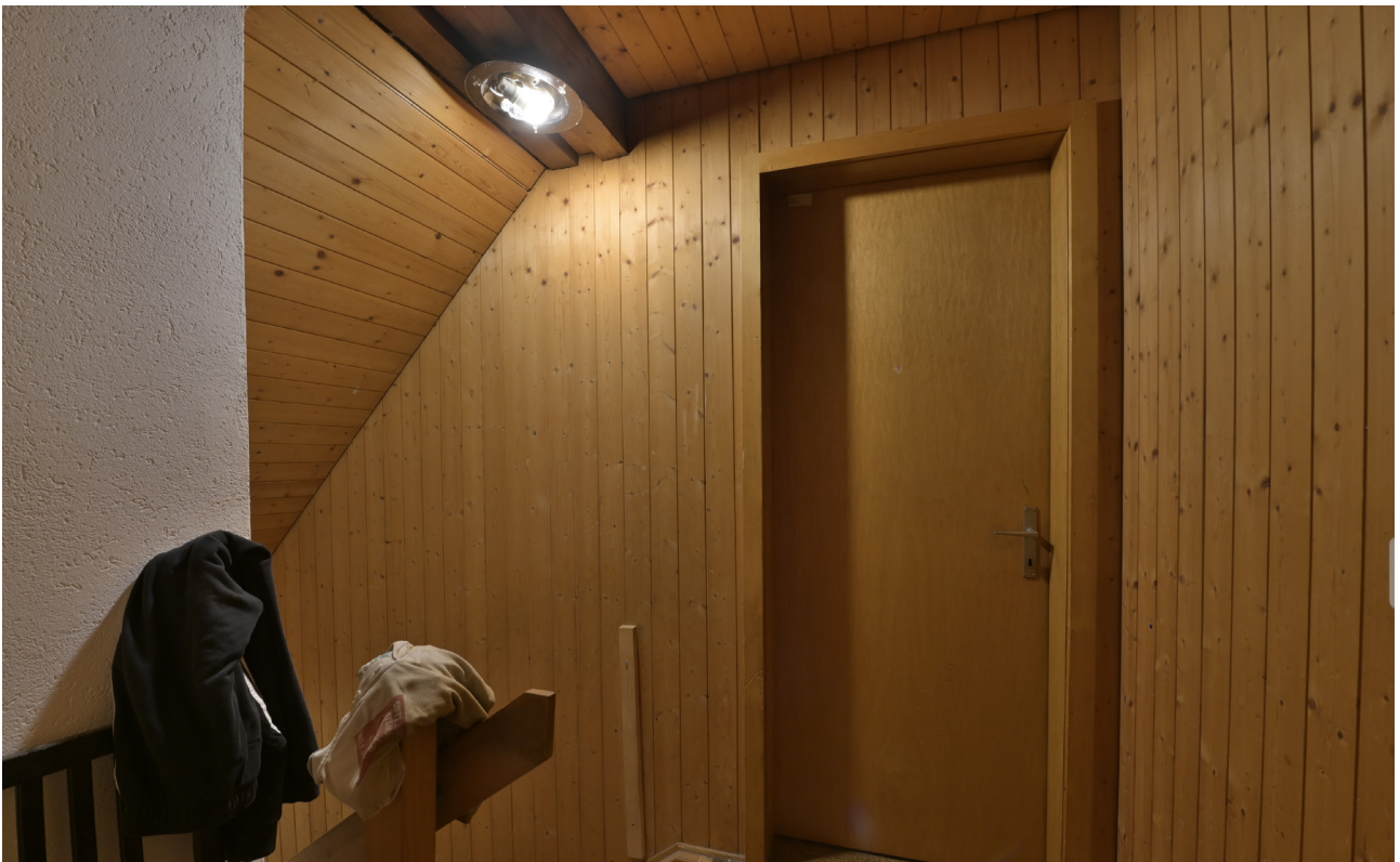
Jakob-Stutz-Strasse 54, Ansicht des ausgebauten Dachgeschosses im Wohnhaus [vestigia 08.06.2022]
