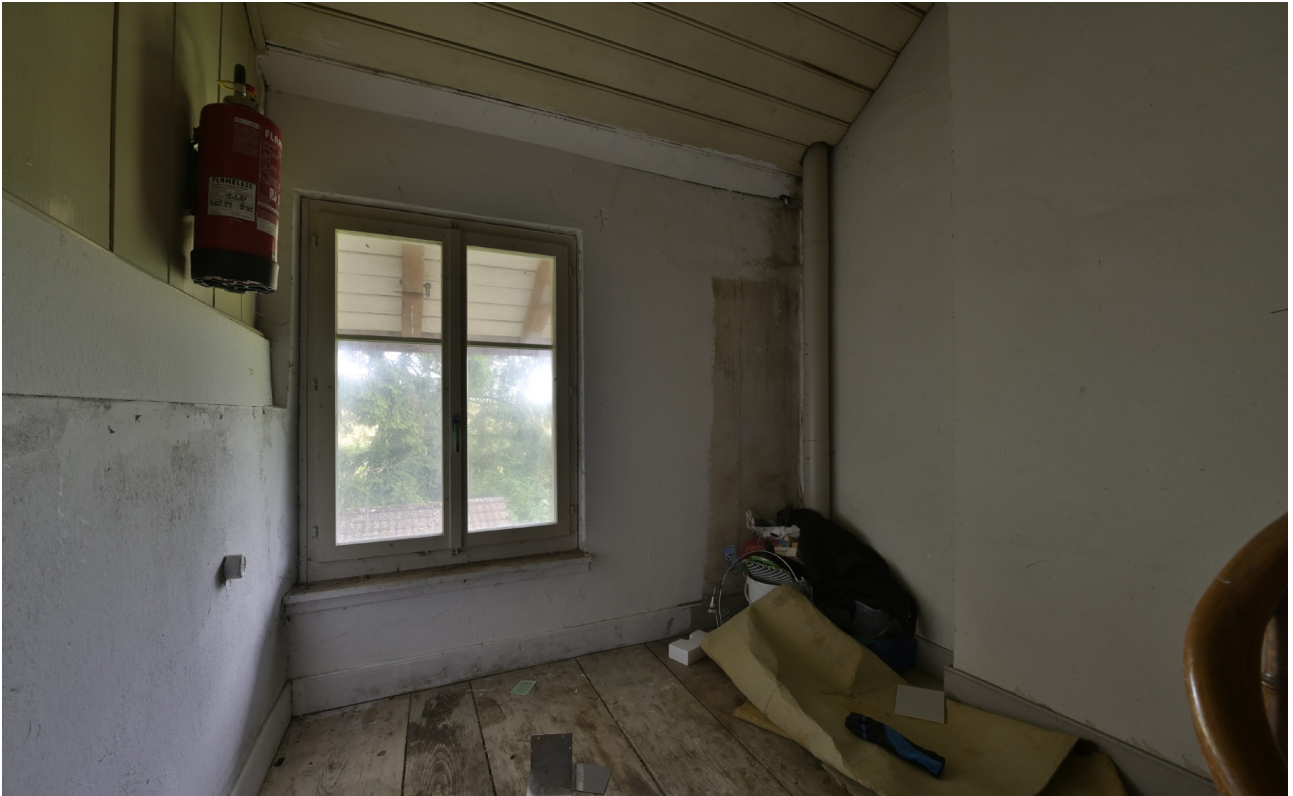
Jakob-Stutz-Strasse 54, Ansicht eines Raums im ersten Obergeschoss [vestigia 08.06.2022]
