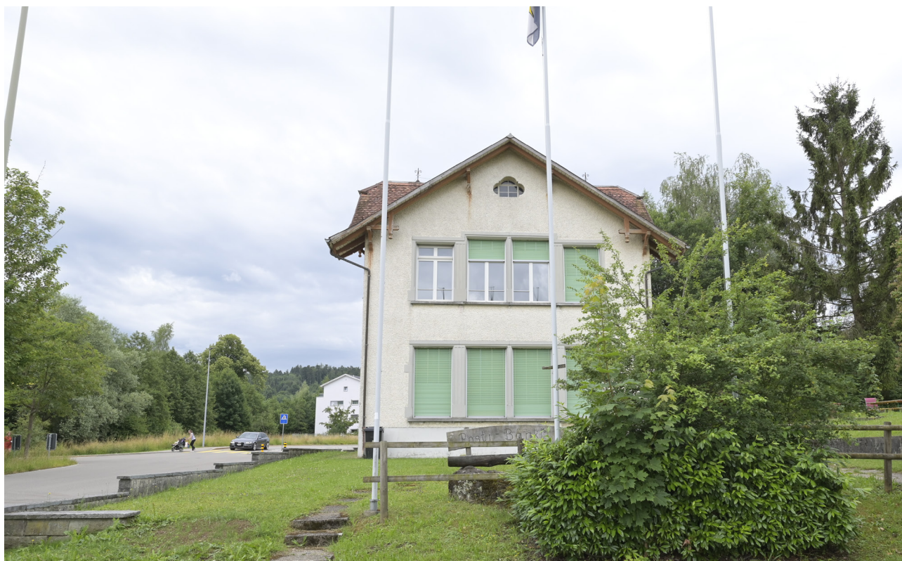
Jakob-Stutz-Strasse 54, Ansicht von Norden [vestigia 08.06.2022]
