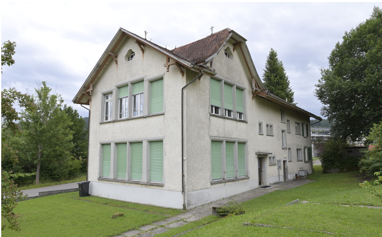
Jakob-Stutz-Strasse 54, Ansicht von Nordwesten [vestigia 08.06.2022]
