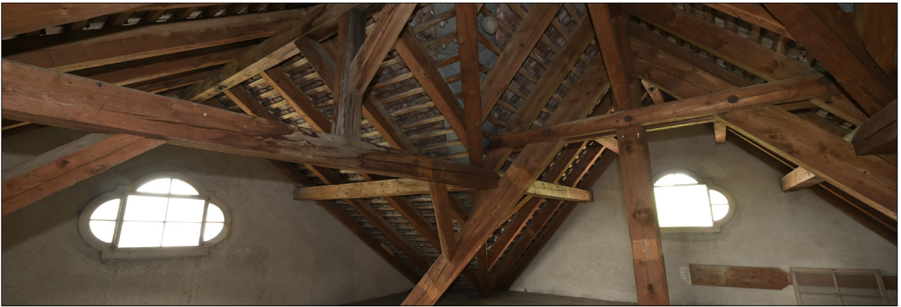
Jakob-Stutz-Strasse 54, Ansicht des Estrichs [vestigia 08.06.2022]
