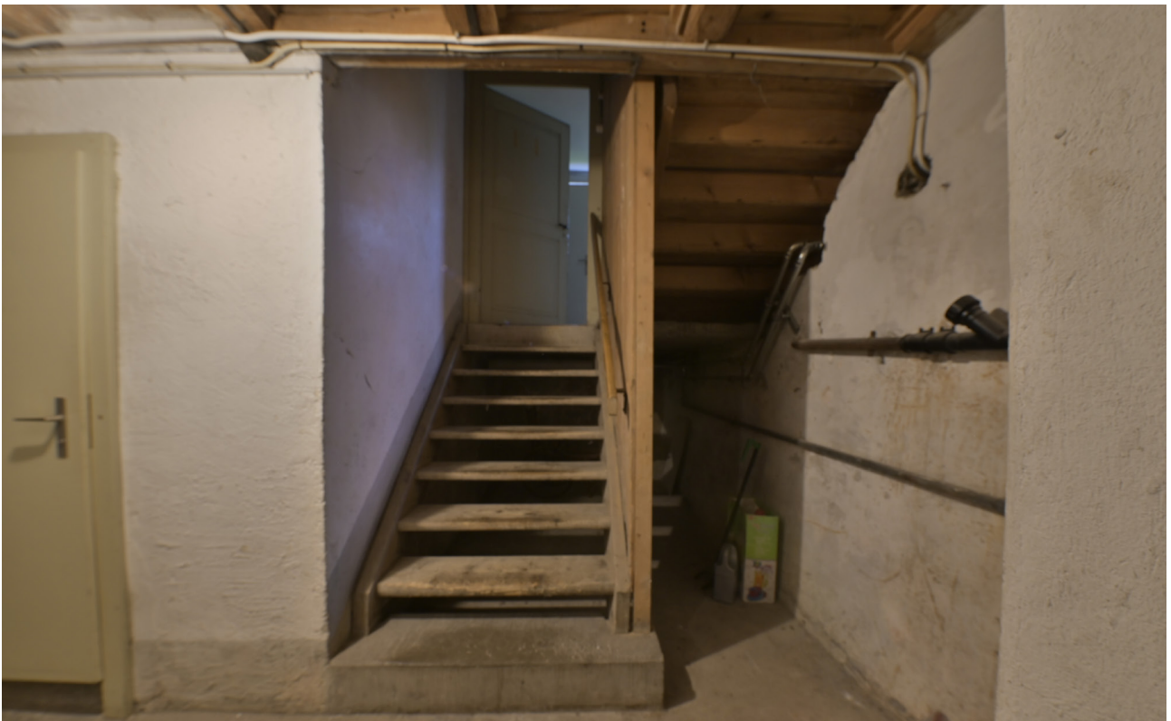
Jakob-Stutz-Strasse 54, Ansicht des Kellers unter dem Wohnhausteil [vestigia 08.06.2022]
